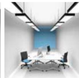
*È possibile raggiungere valori ottimali di distribuzione luminosa con l'impiego di apparecchi a sospensione con distribuzione sia diretta che indiretta del flusso luminoso.*
