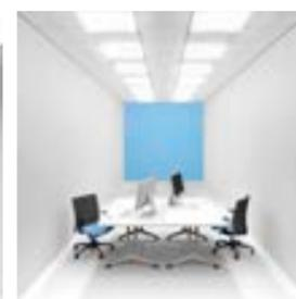
La nuova soluzione con i più recenti apparecchi di illuminazione LED a incasso, con distribuzione diretta e indiretta del flusso luminoso verso il soffitto. Il soffitto è ben illuminato e la camera appare otticamente più grande. Questa soluzione soddisfa i requisiti LG7.
