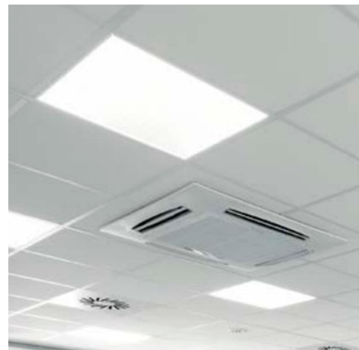
Si stima approssimativamente che per 2,5 W di energia per l'apparecchio illuminante, si consuma 1 W in climatizzazione, ovvero se il consumo energetico del sistema d'illuminazione aumenta, anche il consumo di energia per il condizionamento dell'aria cresce in proporzione diretta.
